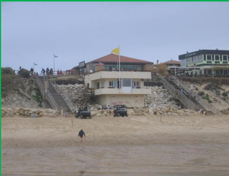
Mise en place d'un enrochement pour tenter de ralentir l'érosion des fondations du poste de secours.
