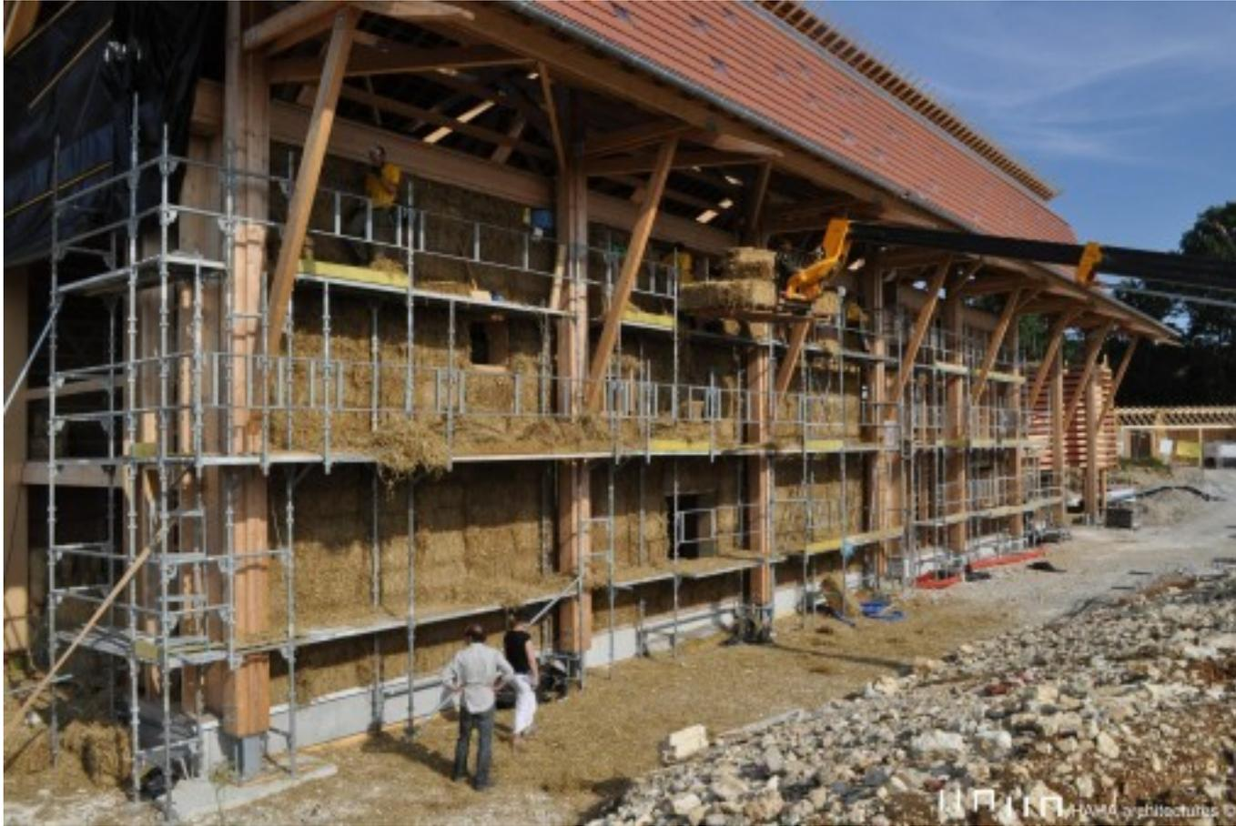
1121 m<sup>2</sup>, c'est la surface utile du bâtiment. 250 m<sup>3</sup> de bois ont été utilisés pour la construction de la Damassine. Le douglas, naturellement résistant et ne nécessitant pas de traitement, sert à la structure ouverte ; il provient de la Forêt noire. L'épicéa, également issu de la Forêt noire, est utilisé pour la structure des murs porteurs en « lamellé collé ». Quant au mélèze, utilisé pour les menuiseries extérieures, il provient des Vosges.
